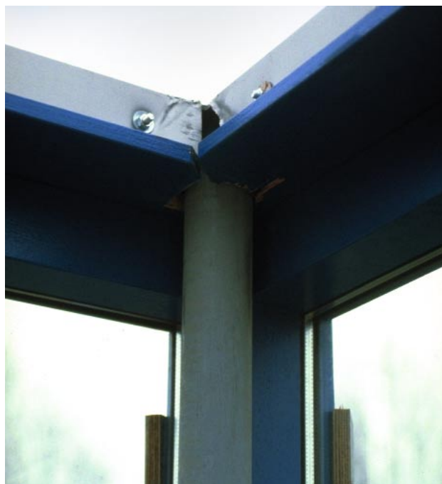
afb. 5.24 Transparante hoekoplossing in staalframebouw aan de Dedemsvaartweg in Den Haag.
