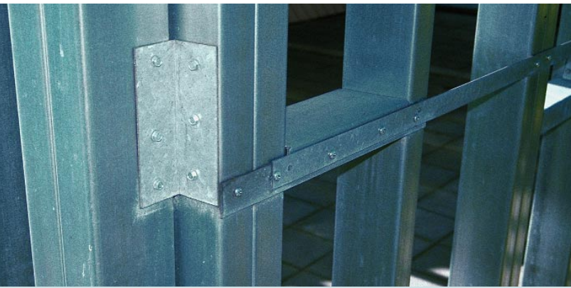
afb. 5.21 Horizontale verbinding tussen op druk belaste C-profielen.
